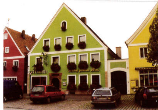
Das gleiche Anwesen nach erfolgreicher Fassaden-sanierung. Gefördert aus Mitteln des kommunalen Förderprogramms
