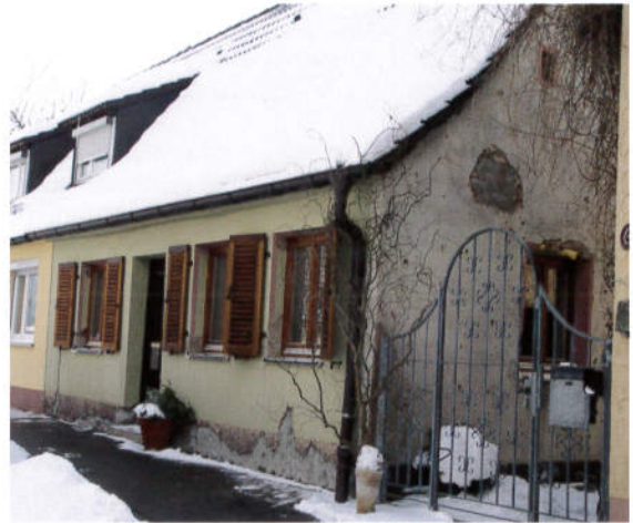
nach der Sanierung der Fenster, dem Anbringen von Fensterläden und dem Entfernen ortsbildfremder Fassadenverkleidung
