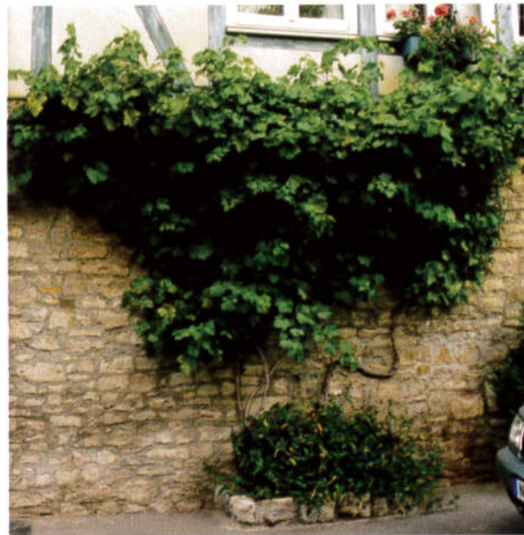
Positivbeispiel: Ein „grüner Fuß“ ist auch aus ökologischer Sicht zu begrüßen und gibt den Gebäuden zudem ein „freundliches Gesicht“. Sehr wirkungsvoll ist auch eine Fassadenbegrünung.
