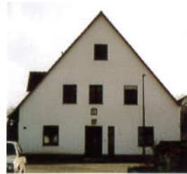
Typisches giebelständiges Haus des Hinteren Marktes mit einfachem Satteldach.
