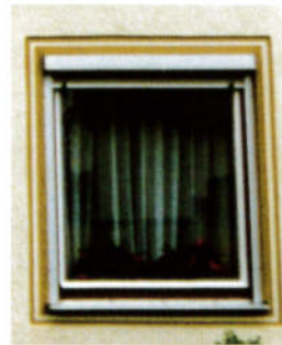
Negativbeispiel: Aufgesetzte Rollokästen stören das Erscheinungsbild der Fassade.
