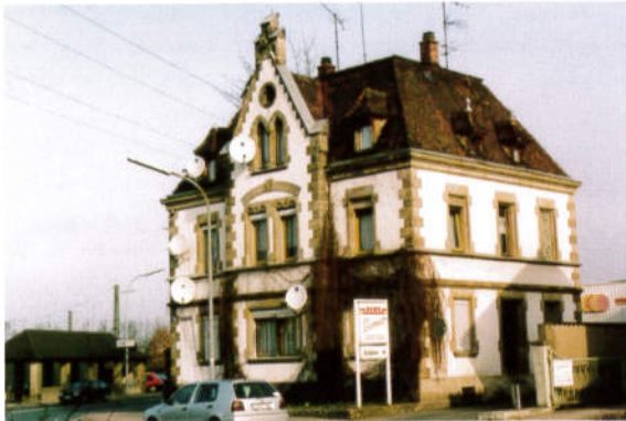
Nicht nur Dächer sondern auch Fassaden werden durch Satellitenempfangsanlagen verschandelt.
