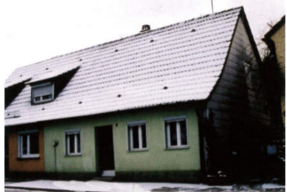
vor der Sanierung
