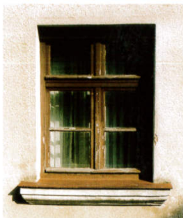
Positivbeispiel: Altes Fenster aus Holz mit Kämpfer, geteiltem Oberlicht und Sprossenunterteilung . (Galgenfenster)
