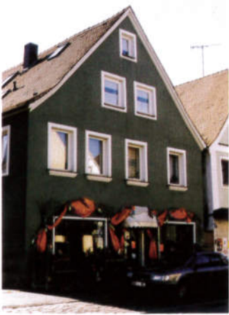
vor der Sanierung
