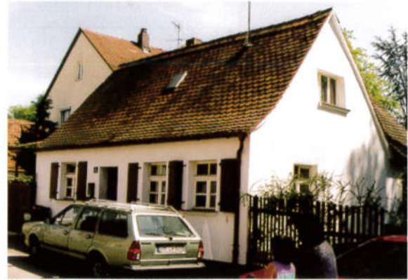
Positivbeispiel: Harmonische Fassade durch den Erhalt der Fensterläden bei der Renovierung.
