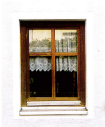
Negativbeispiel: Dieses neue Holzfenster würde von den Proportionen besser aussehen, wenn die Teilung konstruktiv ausgeführt worden wäre.
